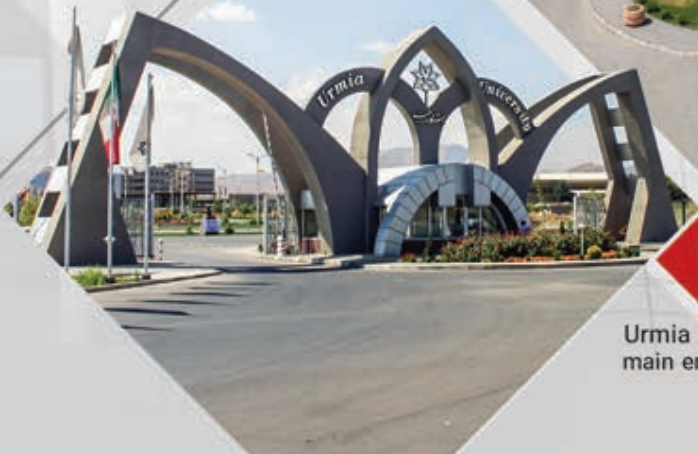
سردر ورودی اصلی دانشگاه ارومیه کارفرما: دانشگاه ارومیه
